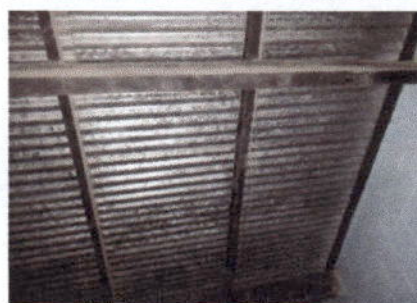
Foto 4: Sustitución de soporte de madera por metal.
